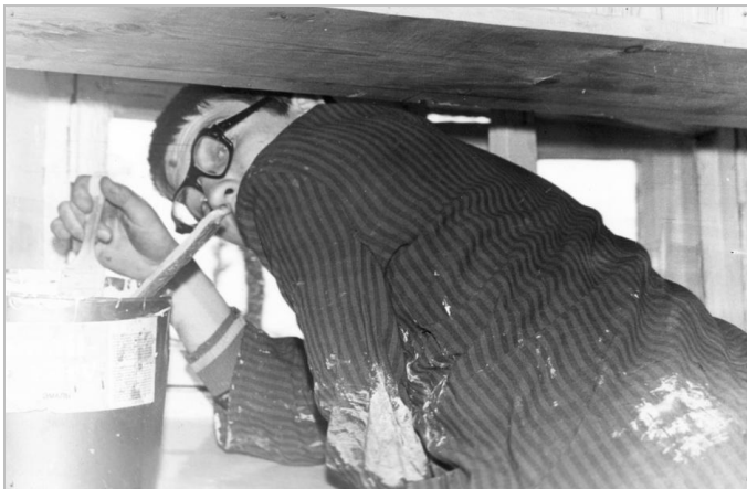
Arvo Viltrop komsomolitoa ehitusel akent värvimas
